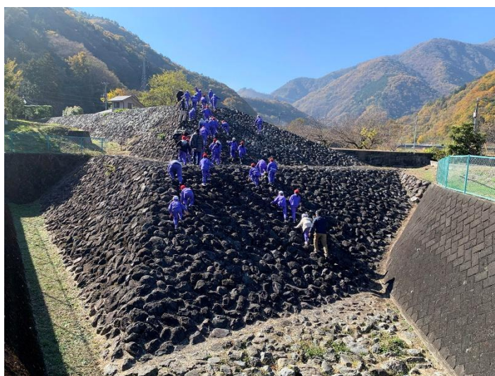
図1-65 石積出三番堤 扇状地全域を守っていた巨大な堤防を体感する学習
