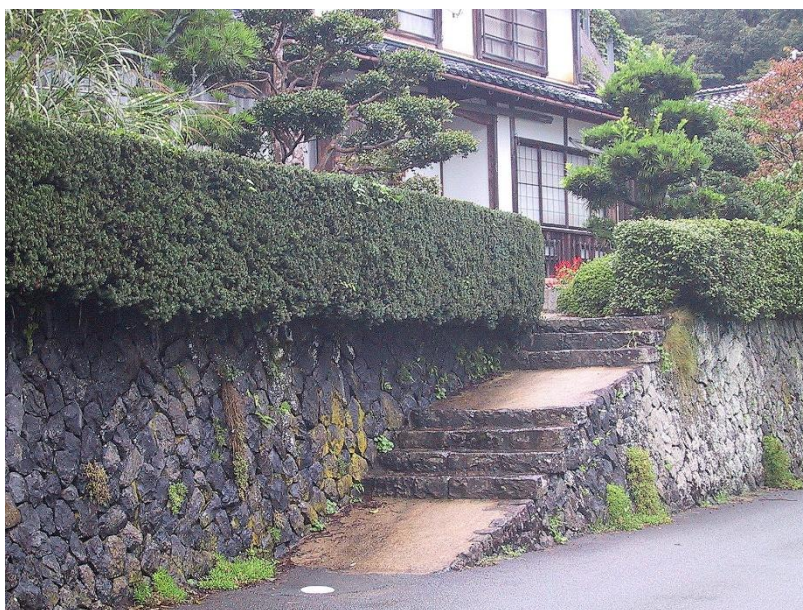
図1-61 水害を凌ぐため天然記念物「玄武洞」の石材を積んだ上に建てた豊岡の家屋（桂撮影）
