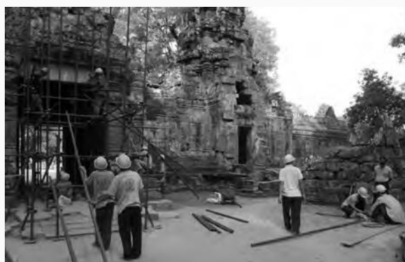
写真 2. 西部門プリア・カーンの緊急補強のための足場を構築する WMF チーム。
