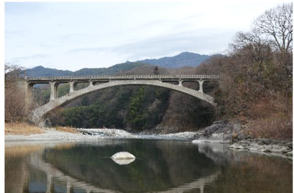
橋長 78mの大規模な鉄筋コンクリート造アーチ橋で、アーチには放物線を用いる。部材の接合部を曲面状になめらかに仕上げ、アーチ隅部には面取りを施すなど細部に配慮した丁寧な施工である。
