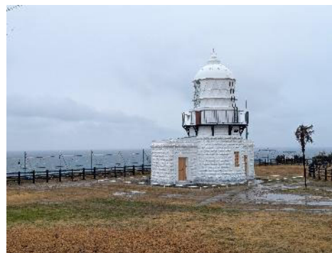
外観 南西より
