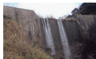
五助堰堤（兵庫県）
