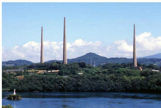
旧佐世保無線電信所は、佐世保市南部の針尾島に所在する海軍が建設した長波無線通信施設で大正11年に竣工した。三基の無線塔を一辺300mの正三角形の頂点に配置し、その中心に通信局舎である電信室を配置する。設計は佐世保鎮守府建築科により、工事監督を吉田直が担当した。
