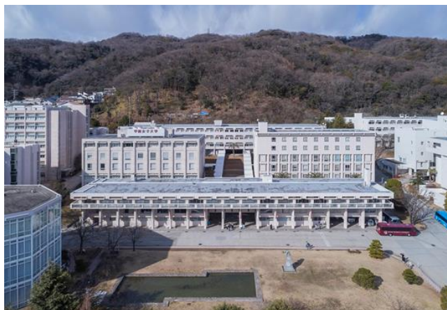
撮影者：新建築写真部
