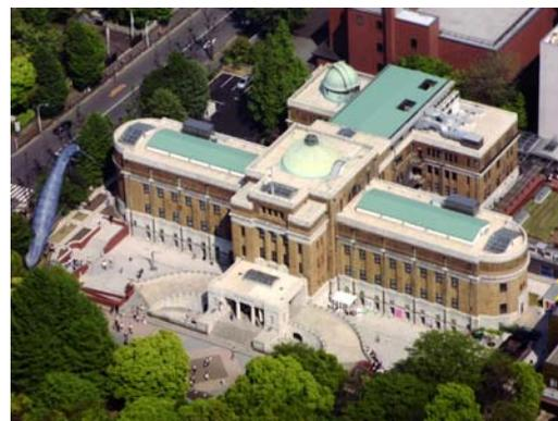
本館は飛行機型の平面をもち、構造は、鉄筋コンクリート造を基本とし、地上3階、一部4階、地下1階建である。
