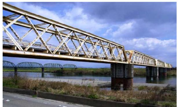
橋長325.1m、下路式の錬鉄製五連トラス桁橋で、わが国で最初に完成した幹線鉄道である東海道線において、最も高度な技術を駆使して建設され、かつ唯一原位置に残る遺構として貴重である。わが国の近代最初期に導入されたイギリス鉄道技術の特色を顕著に表すばかりでなく、明治期に全国で建設された大規模鉄道橋梁の一つの規範を示すものとして、鉄道技術史上、高い価値がある。
