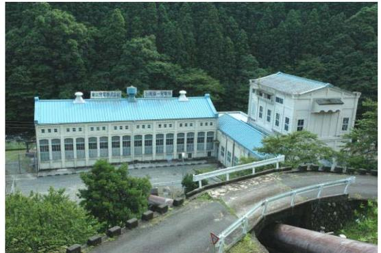
近代日本有数の銅山として知られる日立鉱山を代表する施設の一つとして、産業技術史上、高い価値があり、また、施設全般にわたって、鉄筋コンクリート技術を用いたわが国で最初の発電所施設である。とりわけ本館は、わが国に現存する最古級の鉄筋コンクリート造建築物として貴重である。
