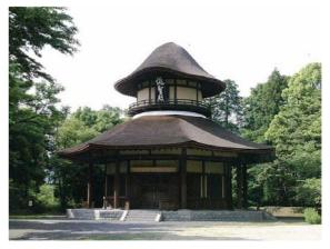
八角形平面の一階に円形平面の二階を載せた構成で、上層屋根は変形の宝形造とし、 <sup>しわたがき</sup> 屋根は上層、下層とも檜皮葺である。また柱や梁など主要部材には円形断面の木材を使用 している。
