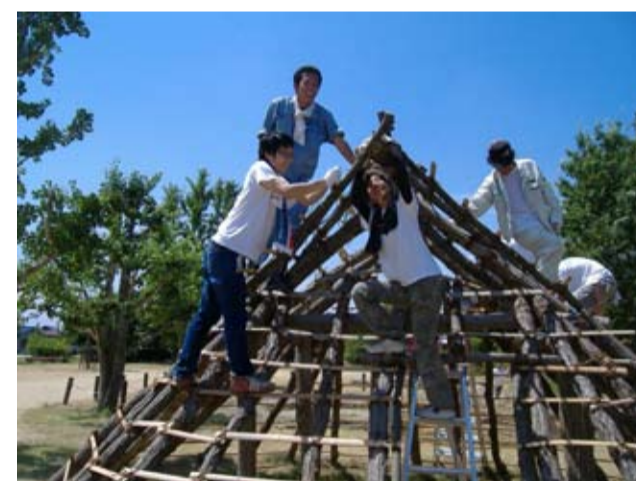
(写真4) 構造材の建て込み
