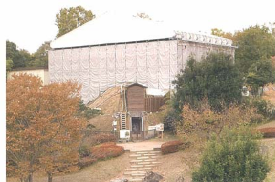
▲墳丘上に建てられた覆屋（内部で発掘調査や石室解体に向けた作業を実施）
