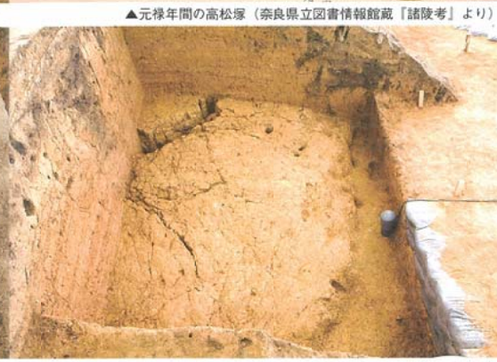
▲版築層をつき破る地震痕跡（北西区。石室直上に大きな亀裂が走る）
