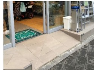
スロープの設置
