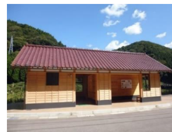
休憩所兼トイレの整備
