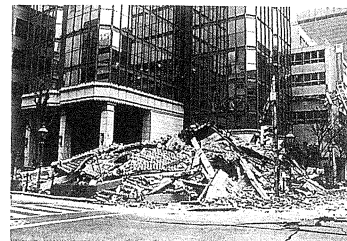
重要文化財旧神戸居留地十五番館：平成7年、阪神大震災で全壊(上)。地盤改良・免震・建物構造補強を総合的にを行い、当初材の7割を再用した(下)。
