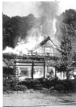
重要文化財大恩寺念仏堂：平成6年、夏休み中のロケット花火で全焼。指定解除となる。
