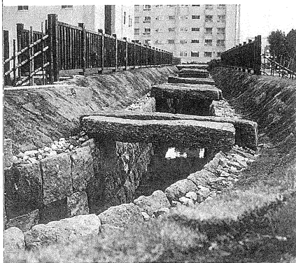
旧神田上水の石垣樋一部復原
