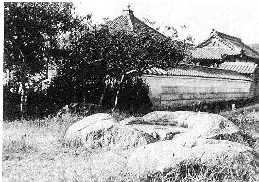
史跡筑前国分寺跡七重塔心礎
