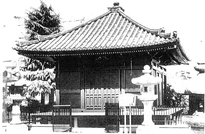
修復された「東照宮本堂」
