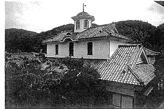
新井旅館青州楼
