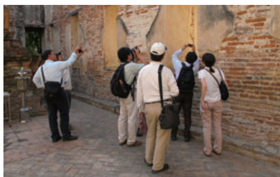
タイ・アユタヤ遺跡洪水被害状況調査 (提供：(独)国立文化財機構東京文化財研究所)
