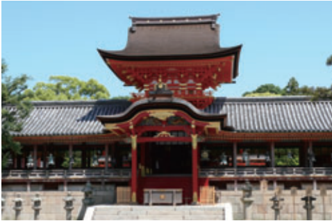
史跡 石清水八幡宮境内 (京都府八幡市)
