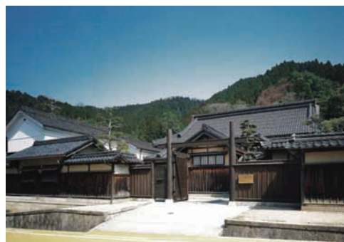
重要文化財 石谷家住宅 (鳥取県八頭郡智頭町)
