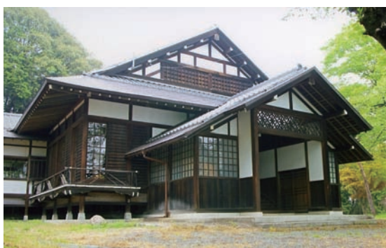
登録有形文化財 富岡市社会教育館講堂棟(群馬県富岡市)
