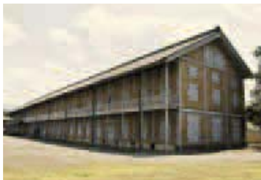
旧富岡製糸場（西園倉庫）（提供：富岡市）
