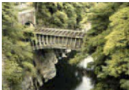
重要文化財 ハツ沢発電所施設（撮影：小野吉彦）
