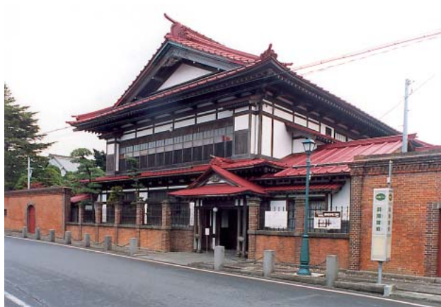
重要文化財 旧津島家住宅（青森県五所川原市）
