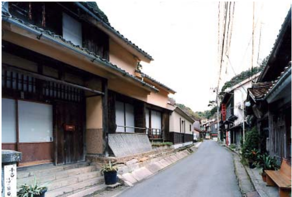
温泉津町温泉津伝統的建造物群保存地区（島根県）
