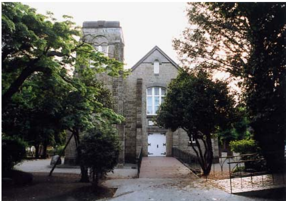
日本基督教団安中教会教会堂（群馬県安中市）
