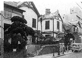
復旧工事に着手した神戸市北野町山本通 (伝統的建造物群保存地区)の洋館
