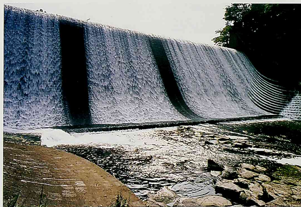
重要文化財「白水溜池堰堤水利施設」(大分県竹田市、同直入郡荻町)
