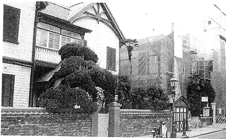
竣工間近の門邸（左）と修理工事中のシユウスケ邸（神戸市・伝統的建造物群保存地区）
