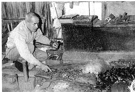
桁に使われる金具づくり作業
