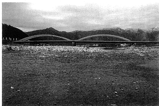
写真3 九頭竜川に架かる福井県勝山市の勝山橋（平成12年竣工）
