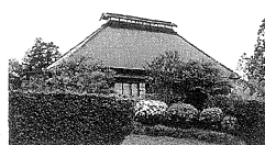
ヒバの生垣越しに大屋根を見る
