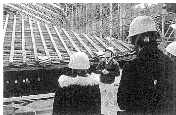
保存修理現場見学（知恩院集會堂）
