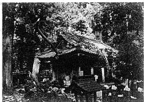
(写真1) 大枝の落下により軒を大破した二荒山神社神輿舎
