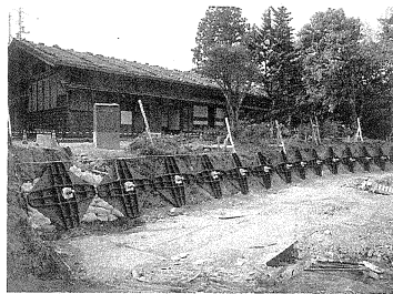
佐々木家住宅（鳥根県）地滑り対策工事 アンカー工施工中
