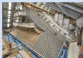
屋根瓦葺(本瓦葺)
