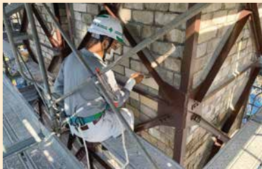
反射炉の煉瓦修理作業
