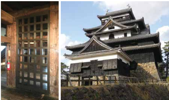
国宝 松江城天守 耐震補強
