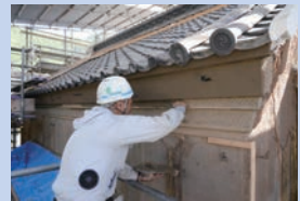
Sakan plastering (Nihon Kabe)
