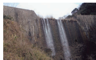
五助堰堤（兵庫県）
