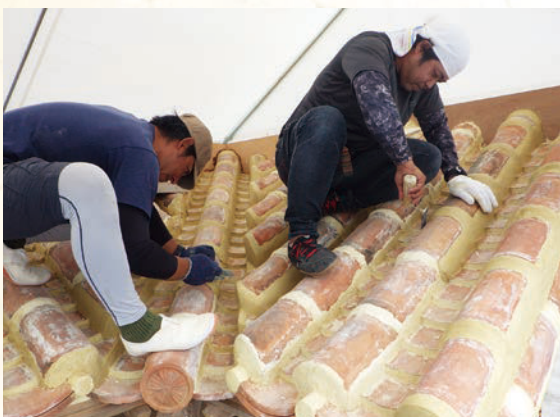
「屋根瓦葺 (琉球瓦葺)」琉球瓦葺技術保存会 (琉球瓦葺の様子)
