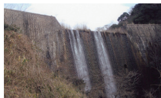
五助堰堤（兵庫県）
