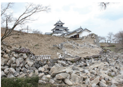
史跡 小峰城跡（福島県白河市）奥州白河藩主歴代の居城。東日本大震災で石垣が崩落（左）、災害復旧事業（中）により復旧（右）（写真提供：白河市）
