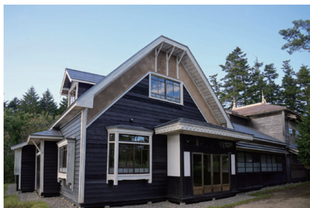
史跡 旧奥行臼駅通所（北海道別海町）近代の北海道内の宿泊、運送の拠点である駅通所を修理（写真提供：別海町教育委員会）
