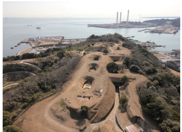
史跡 東京湾要塞跡 千代ヶ崎砲台跡（神奈川県横須賀市）東京湾岸一帯に築かれた砲台群で、砲台跡を修理（写真提供：横須賀市教育委員会）
