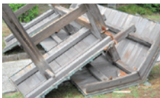
再建前の倒壊した門
