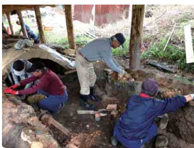
サポーターやボランティアの支援による登窯の修復作業
